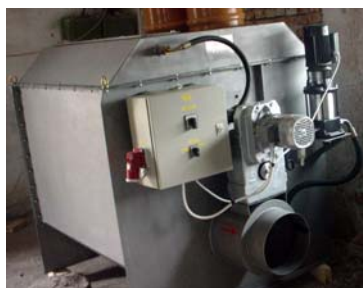
Filtru fix de capacitate medie, de max 800 m 3 /h
